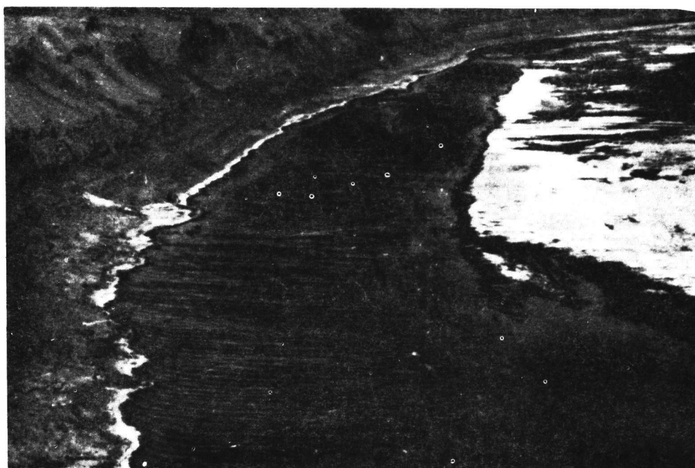
بستر مسیر قنات که از زمینهای شنی عبور می کند و مقدار زیادی آب در زمین نفوذ می کند
